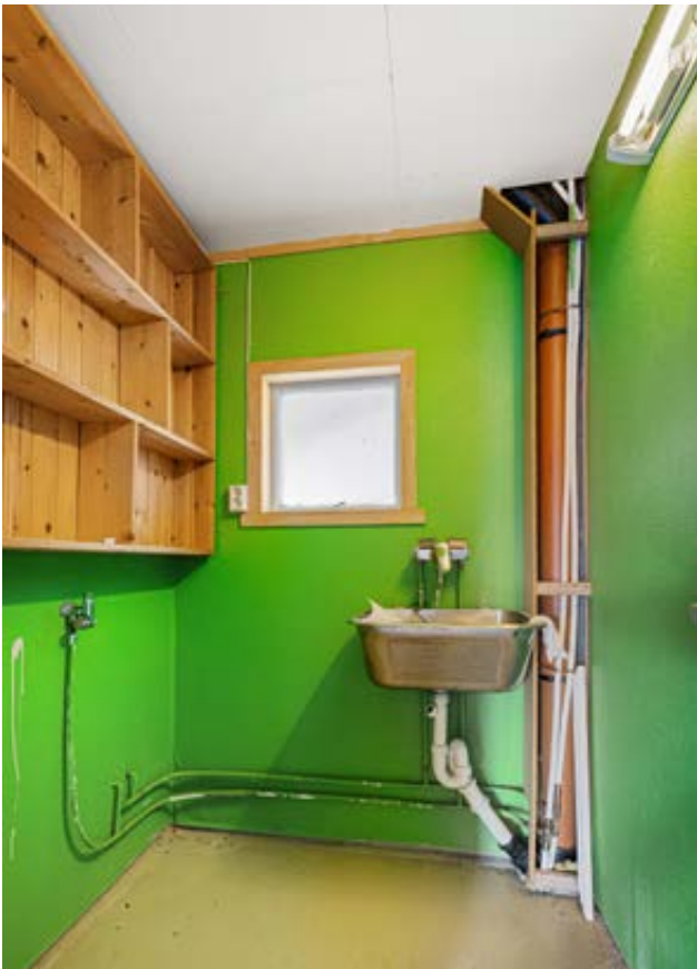
Vaskerom i 1 etasjen
