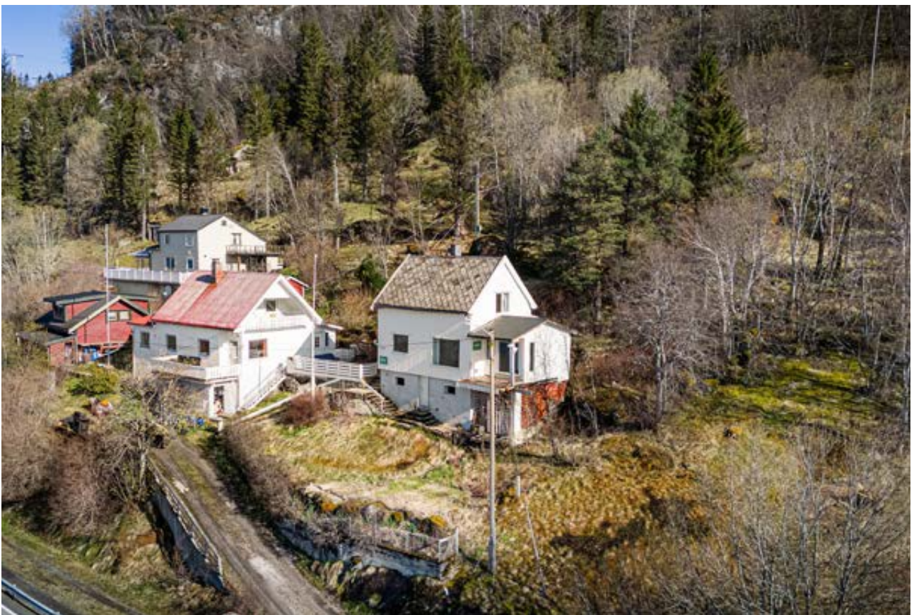
Innkjørsel opp til boligen
