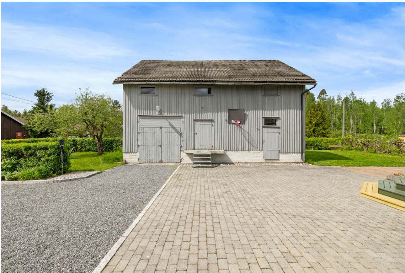
På eiendommen står et stort uthus/låve fordelt over to plan med et samlet areal på ca. 193 kvm. Her er det bl.a garasje plass samt flere rom som kan brukes til lager/verksted.
