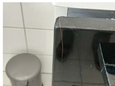
Sprekker på folie til skuffeseksjon.
