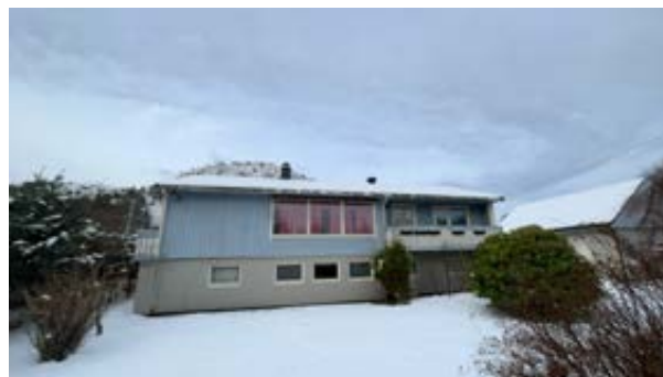
Taket var snødekt under befaring.
