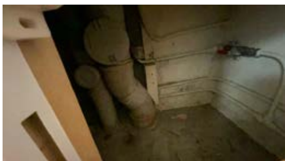
Avløpsrør med stakemulighet.
