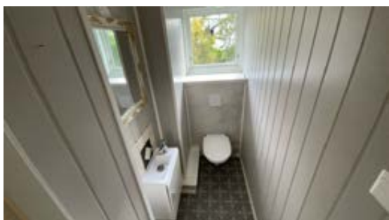
Toalettrom i hovedetasje.
