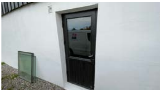
Dør fra vaskerom. tilhørende hovedenhet.
