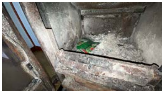
Sprekker i ildfast stein i vedovn i sokkeletasje.
