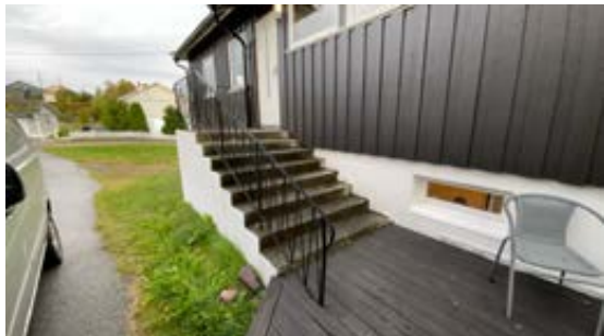
Inngangsparti til hovedetasje.
