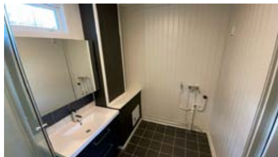
Bad/vaskerom i leilighet sokkeletasje.
