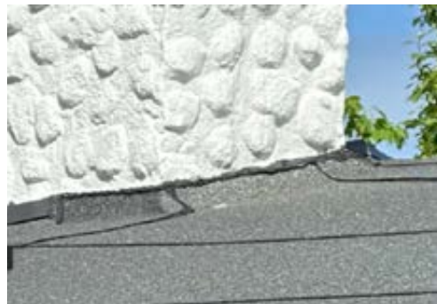
Overgang taktekkning mot pipe
