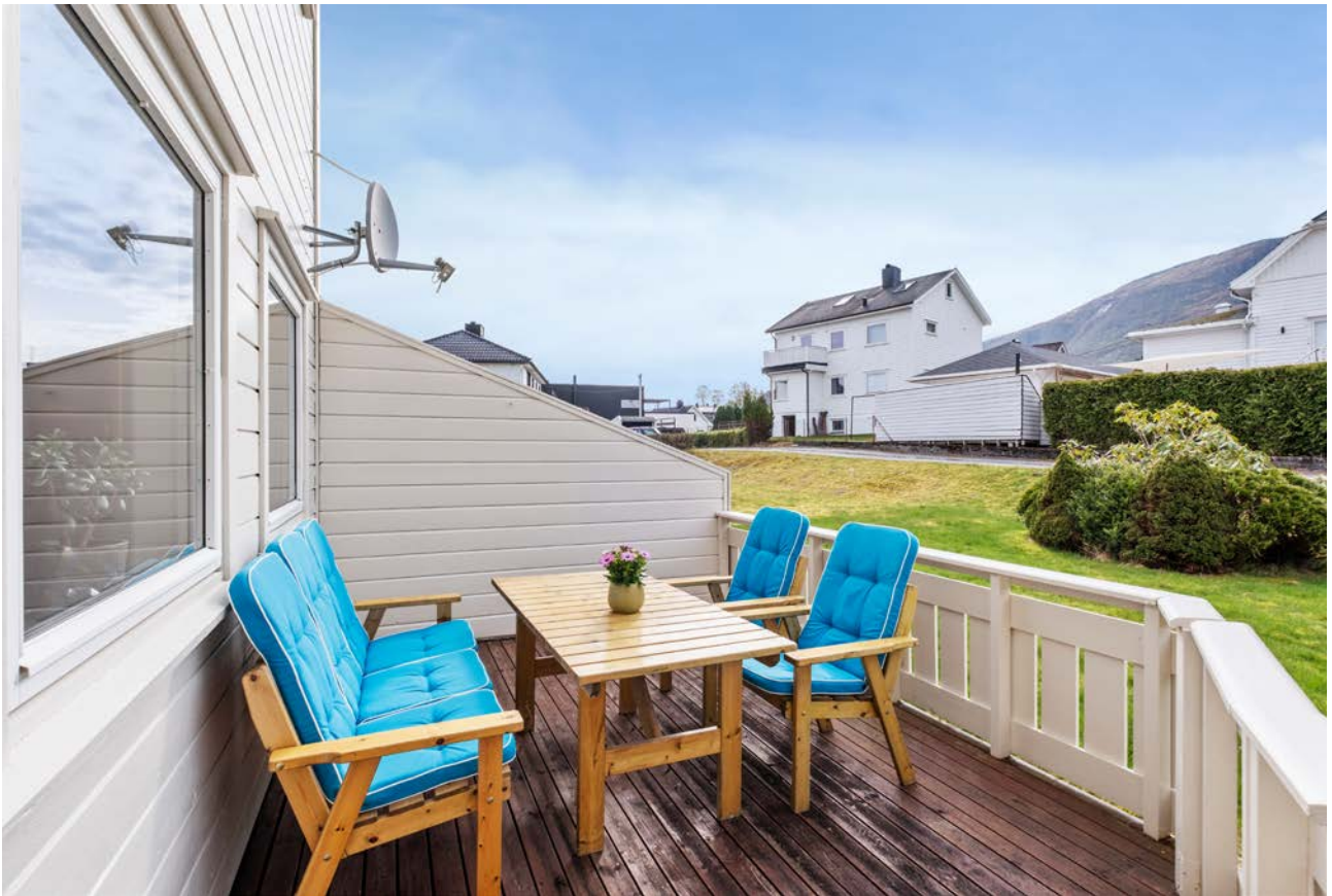
Terrassen er utvidet i forhold til byggemeldt tegning
