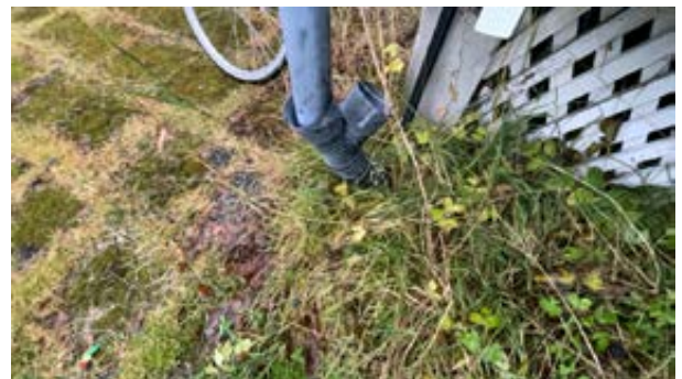
Drensrør benyttet til taknedløp tyder på at det er montert drensrør i grunn.
