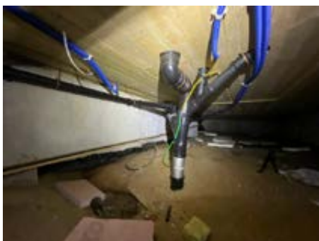
Avløpsrør i krypekjeller.
