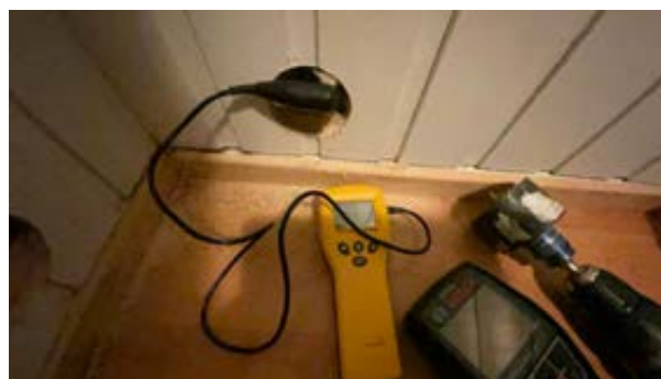
Hull for fuktkontroll boret fra gang.
