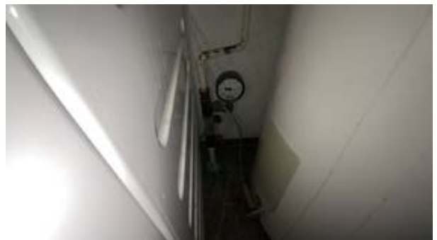
Trykkmåler bak bereder,
