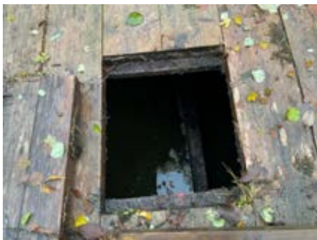
Inspeksjonsluke i lokk.
