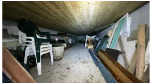
Krypekjeller med støpt gulv på grunn.
