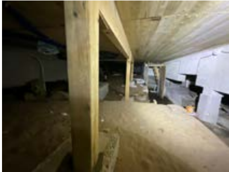
Bærende drager i betong under gulv.
