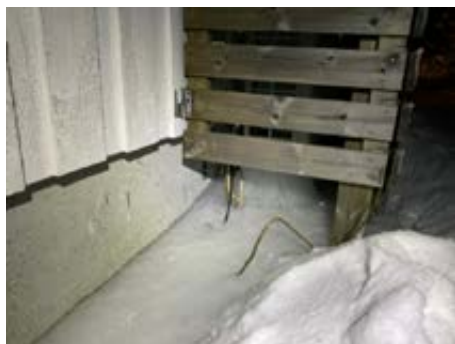
Is under og i ute del av pumpen.
