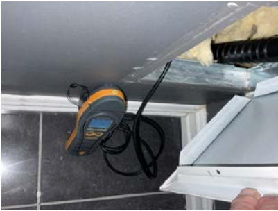
Hulltaging og fuktsøk
