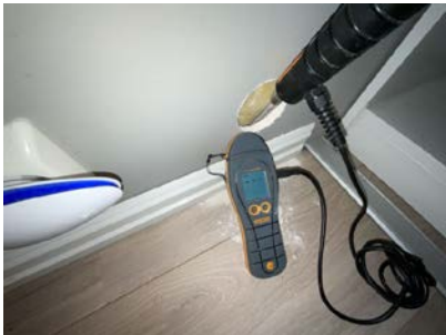
Hulltaking og fuktsøk
