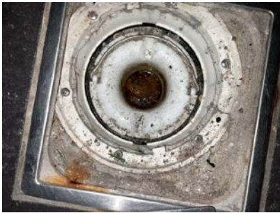
sluk, membran og tettesjikt
