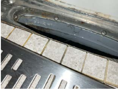
sluk, membran og tettesjikt
