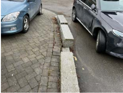
støttemur av steinblokker
