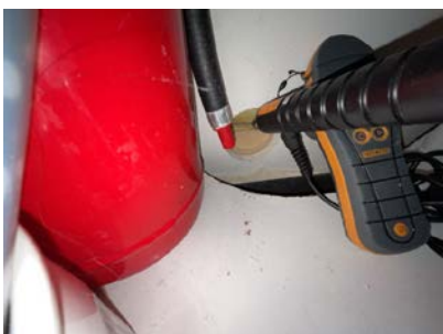
Hulltaking og fuktsøk
