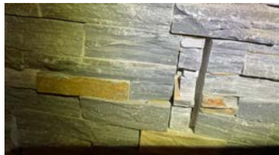
Gliper mellom element, bruk av mindre element
