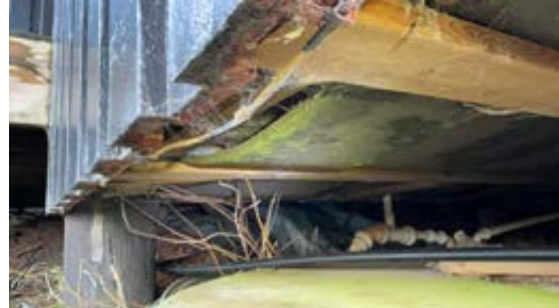
Vindsperre med åpning
