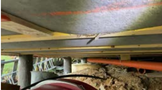
Vindsperre med åpning
