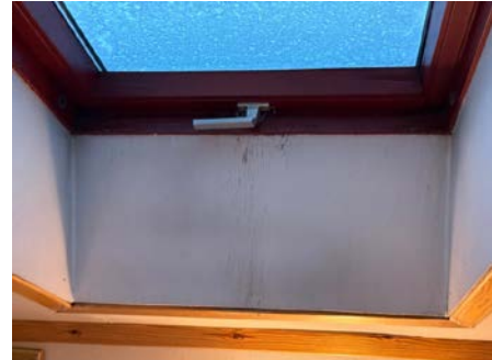
Eldre lekkasjemerker under et takvindu
