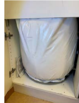
120 liters bereder i benk 7 etg fra 2022
