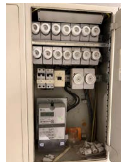
Elskap med skrusikringer, plassert i fellesgang.
