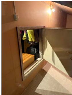
Rømningsdør for evakuering, loft
