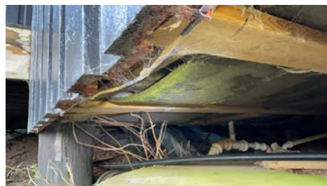
Vindsperre med åpning
