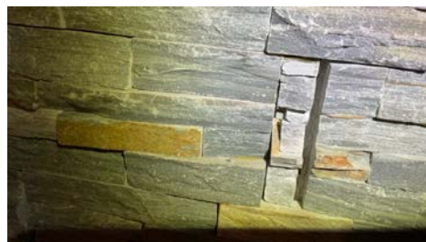
Gliper mellom element, bruk av mindre element
