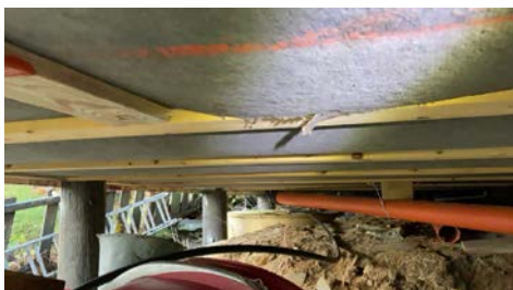
Vindsperre med åpning
