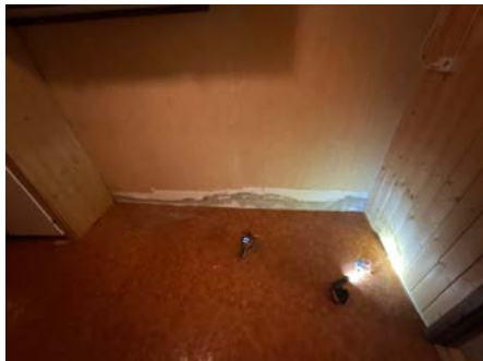
En del salt/kalkutslag i trappegang, her er det ikke montert EPS-fuktsikring.
