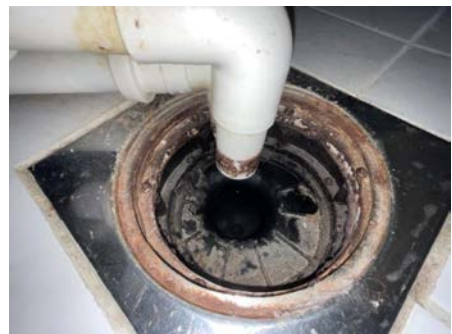
Sluk. Ikke mulig og avklare om membran er klemt under klemring.
