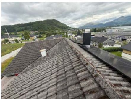
Oversiktsbilde av takteking.
