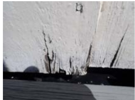
Råteskadet bordkledning
