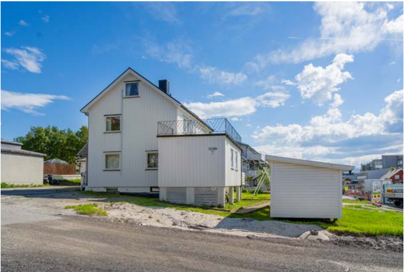
Innkjørsel med parkeringsplass
