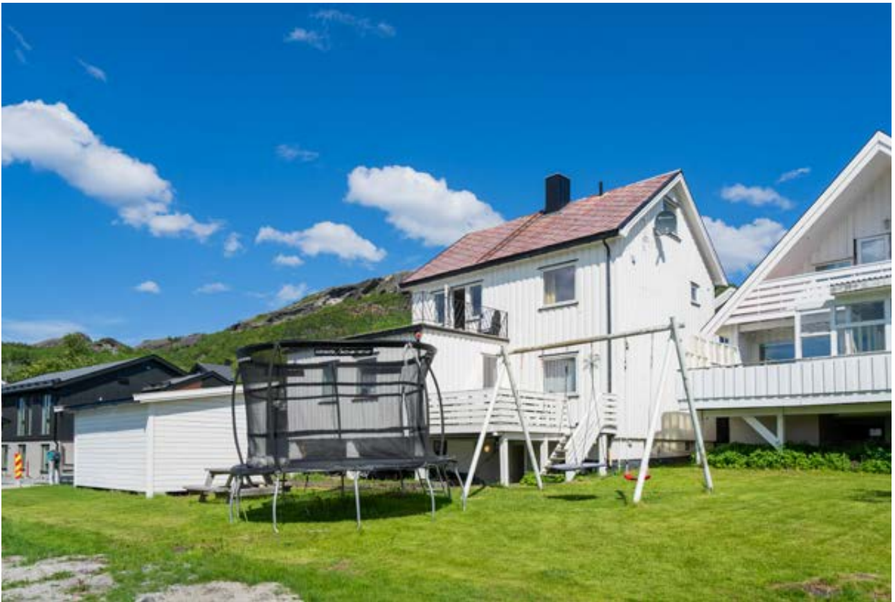
Baksiden av boligen med hage
