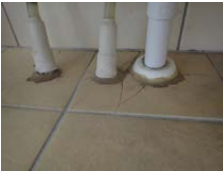
Utett rørgjennomføringer
