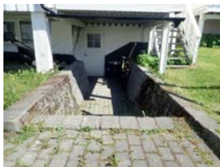
Forstøtningsmurer ved kjellerinngang.
