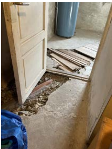
Åpent gulv i kjeller
