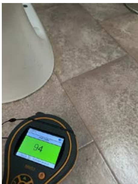
Ingen indikasjon på fukt på Toalettrom
