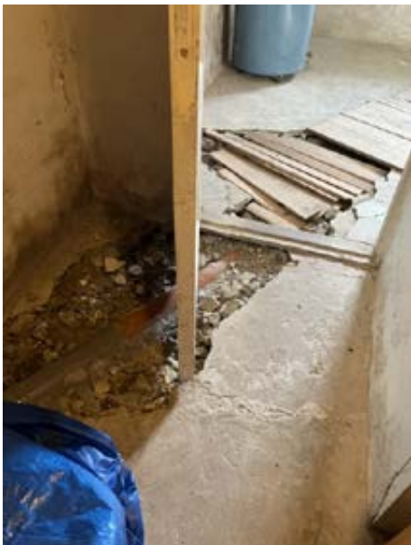
Gulv er pigget opp i forbindelse med utskiftning av avløprør
