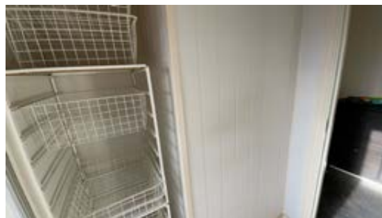
Teglsteinspipe er ikke synlig på alle fire sidene.
