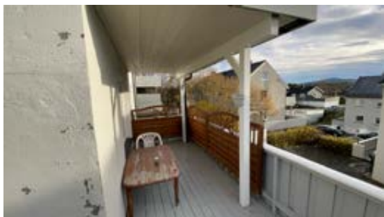
Overbygd veranda mot syd.
