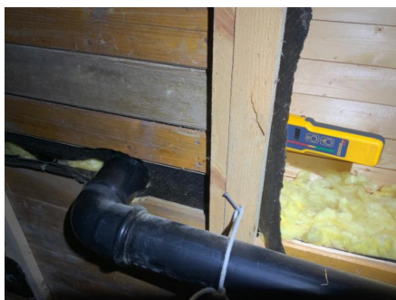
Fuktmåling ved sluk.
