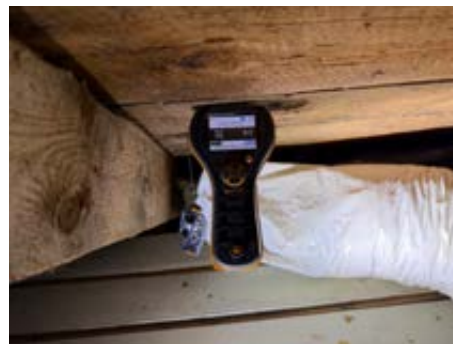
Fuktmåling i undertak, ikke utslag på fukt.
