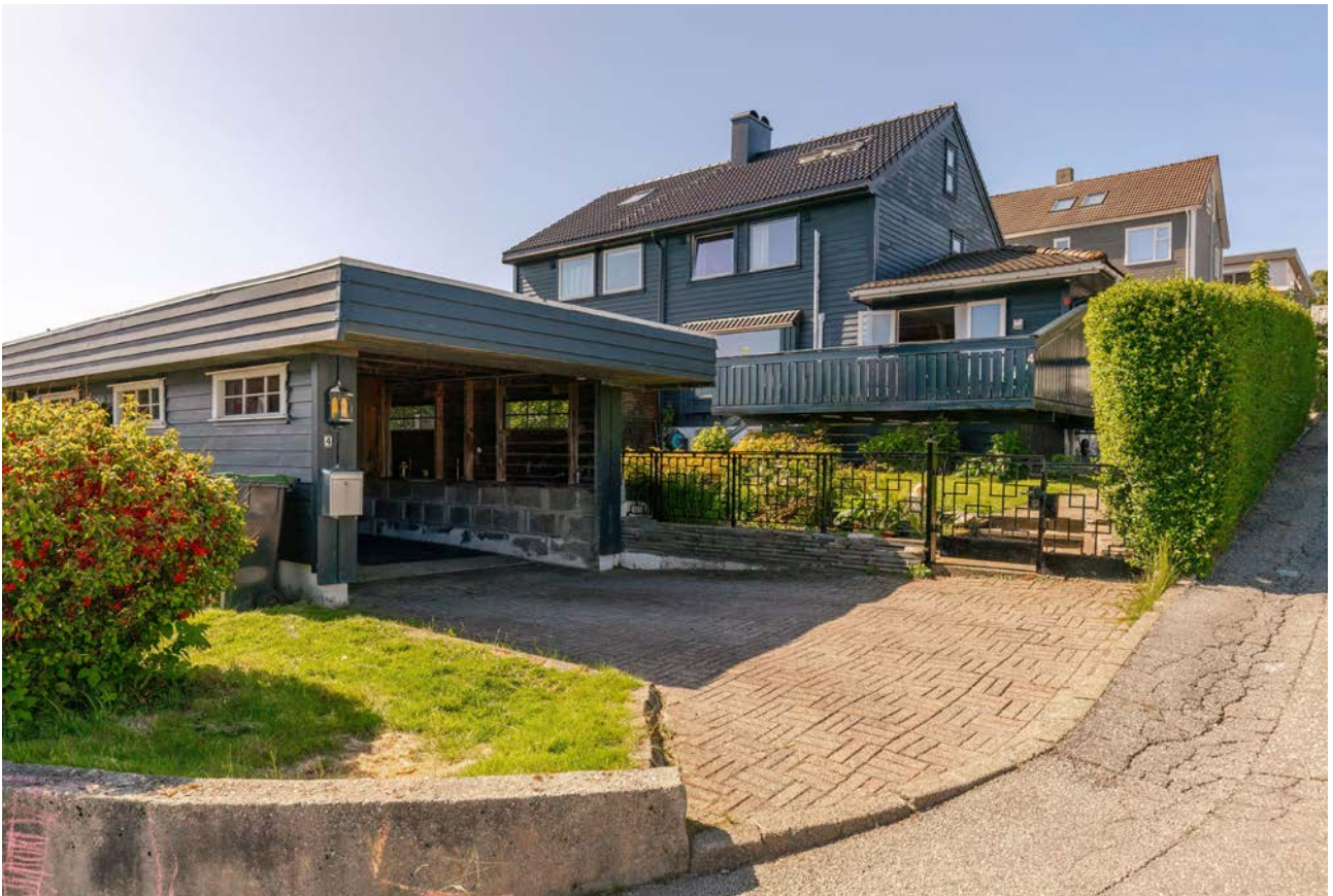
Fasade - parkering i carport
