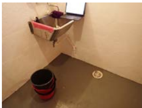
Malt betonggolv og malt pusset mur yttervegg og delevegg mot snekkerbod
