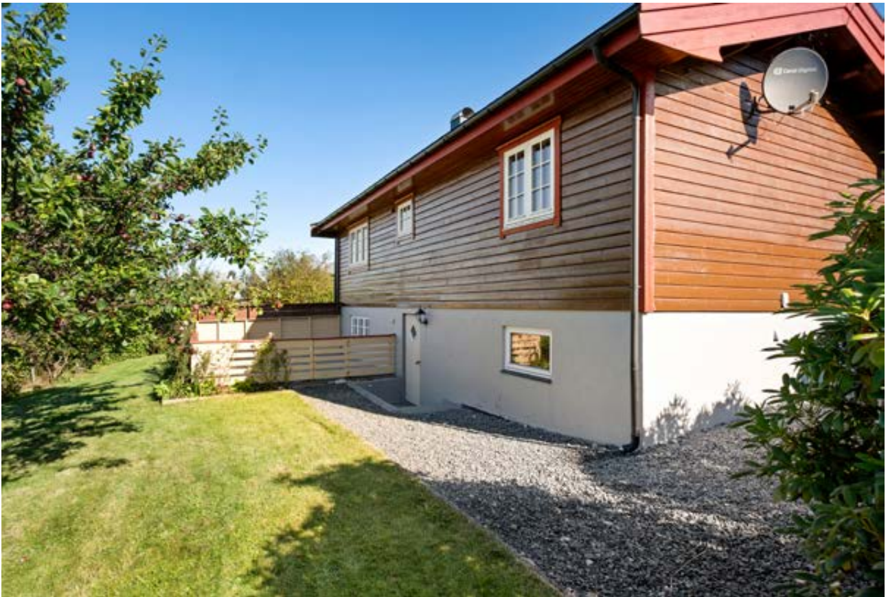
Dør inn til underetasjen
