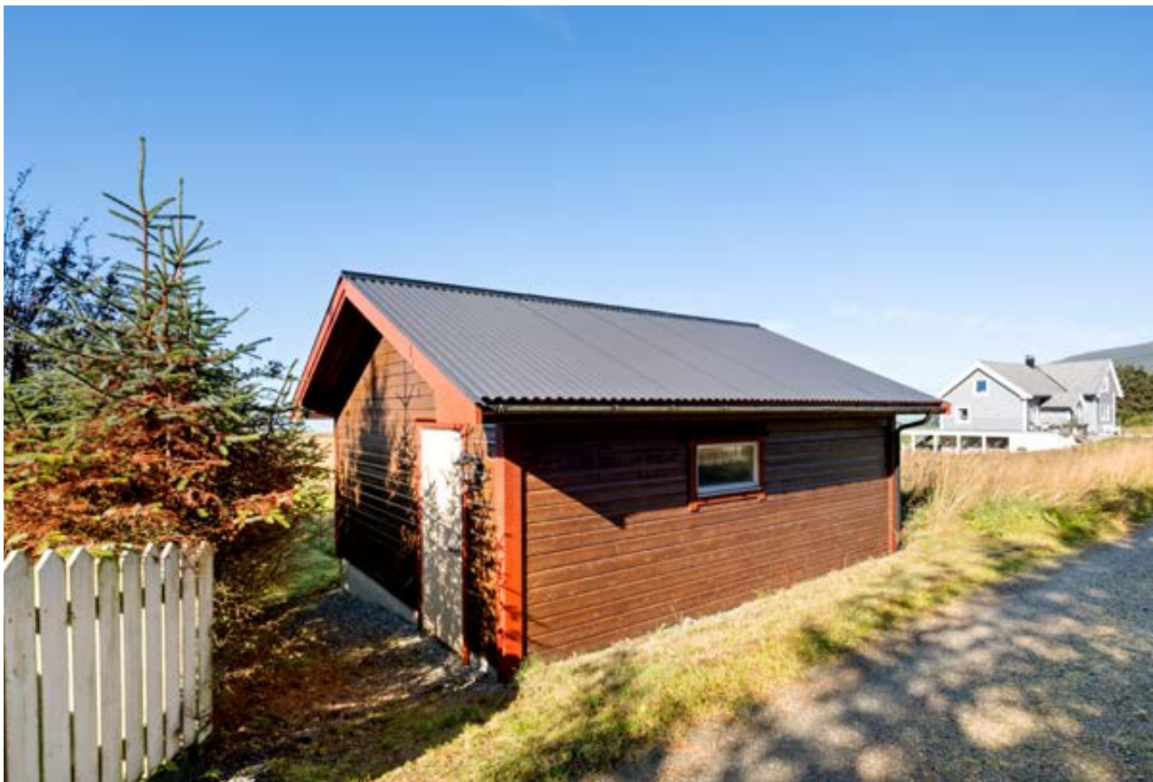
Uthus/snekkerverksted oppført i ca 2011
