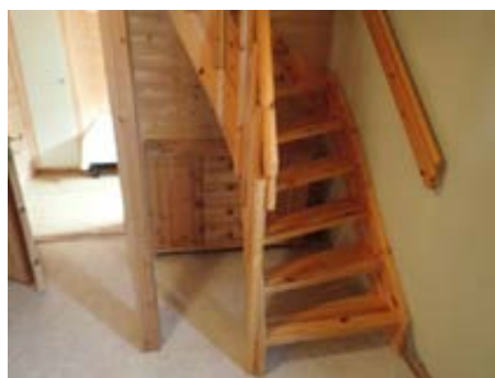
Forholdsvis bratt trapp med noe høyere opptrinn enn vanlig.
