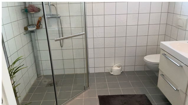
Bad i hovedetasje
