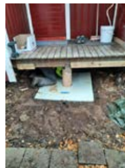
Arbeider vedr. utbedring/ forsterking av søylefundamenter til repos inngangspartiet
