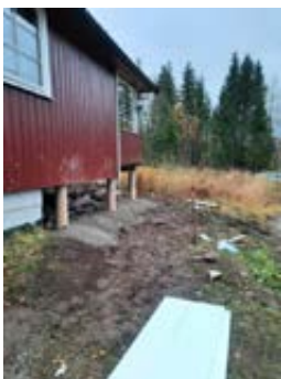
Etablert nye og forsterkede søylefundamenter til deler av hytta
