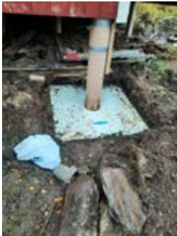
Pågående arbeider vår 2026 vedr. forsterkning søylefundamenter til hytta
