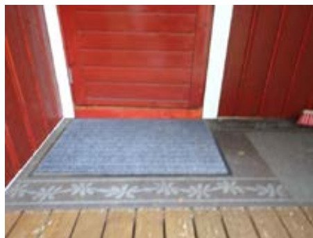
Bilde til deler av plattning til hovedinngangspartiet
