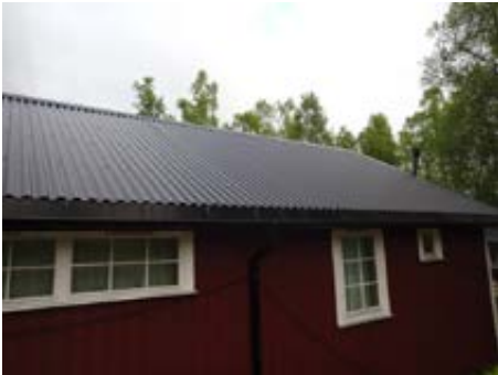
Bilde tatt nært til tak bakside
