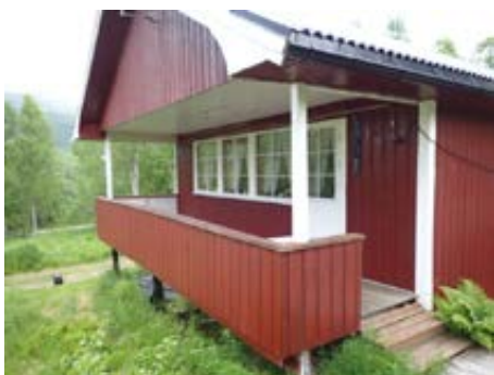
Bilde tatt mot vinduer til gavl stue
