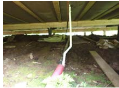
Bilde tatt mot ene avløpsrør for gråvannsutslipp
