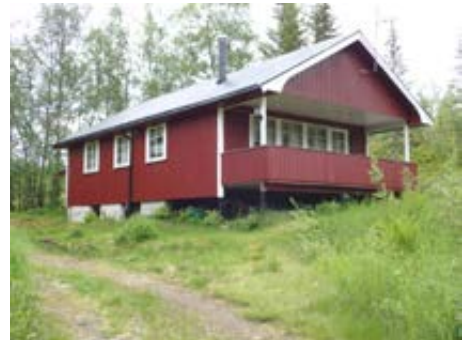
Bilde tatt motside hvor det er etablert stålpipe, Ikke etablert adkomst for feier. Nedløp fra takrenne i midtsone til hytta, ført ned til bakke/ terreng
