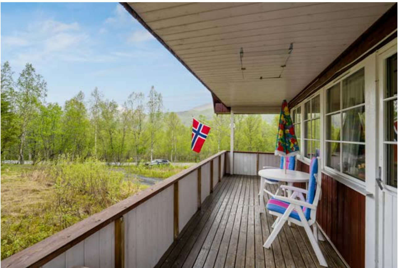
Overbygget terrasse med utgang fra stuedelen og trapp ned til terreng
