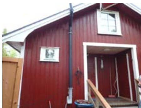
Bilde tatt mot hovedinngangsdør og til sportsbod.
