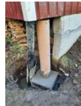
Bilde tatt mot del av forstøtngsmur, nå etablert nye forsterkningsøyer i tillegg til eldre forstøtningmur.
