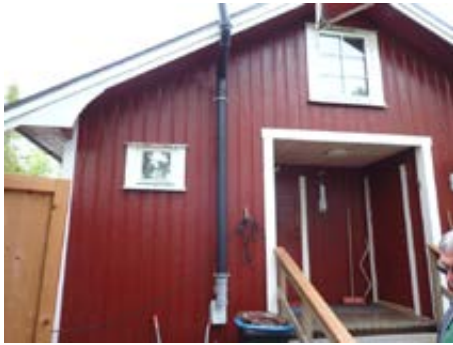
Bilde tatt gavlvegg som viser avtrekk langs vegg og over tak fra innvendige hyttedo i hytta
