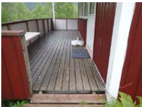
Bilde viser balkong/altan ut fra stue med adkomst til tomt i ene ende
