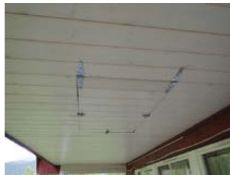
Bilde tatt mot luke til takoverbygget parti til altan, egnet for mindre lagring, lette ting
