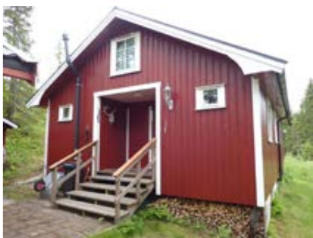
Bilde tatt mot trapp til hovedinngangspartiet
