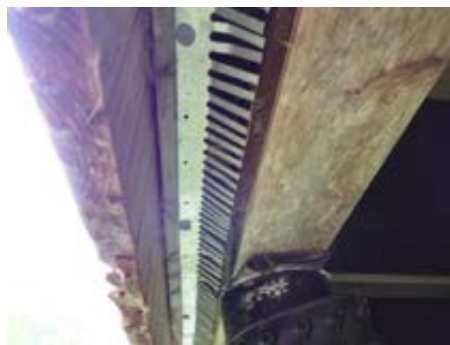
Bilde tatt for å vise at det er etablert musesperre / bånd til hytta
