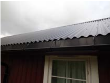
Nærbilde tatt mot yttertak
