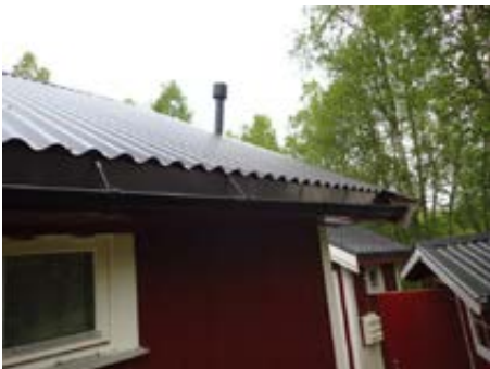
Nærbilde til delr av hyttetaket, nytt yttertak fra år 2020, bilde viser takrenne, beslag i stål.
