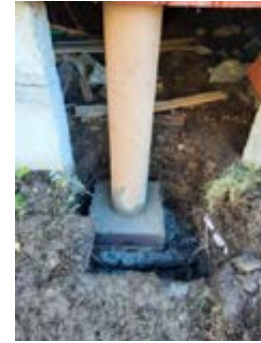
Bilde tatt mot søylefundament under etablering
