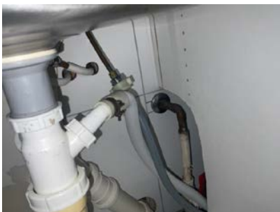
Lekker ifra rør fra servant.
