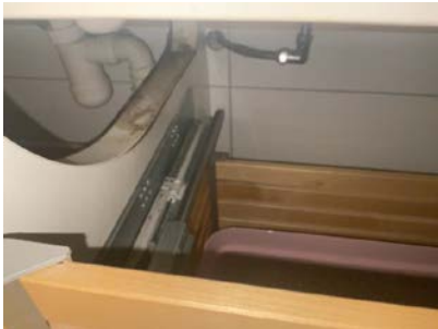
Lekker ifra rør fra servant.
