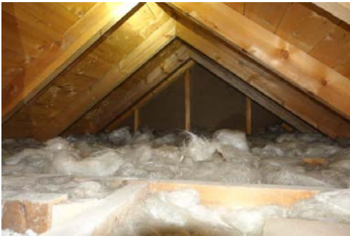
Sperrekonstruksjon/glassullisolasjon
