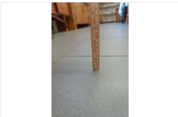
Maks høydeforskjell v/2 m avstand : 12 mm
