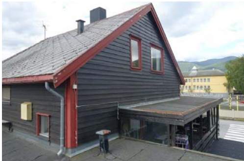
Bortledning via nabotak
