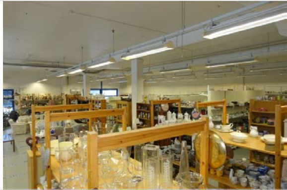
Elementbygg m/søyler, dragere og dekkeelement
