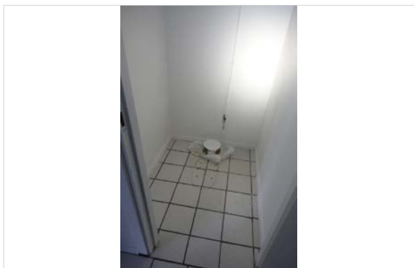
Garderobe-/toalettanlegg er demontert
