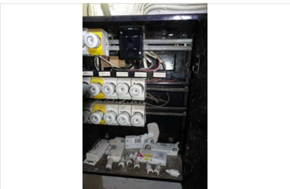
Sikringskap med gamle porselenssikringer
