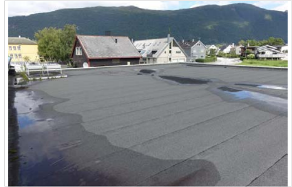
Flatt tak m/innv. nedløp (3 sluker)
