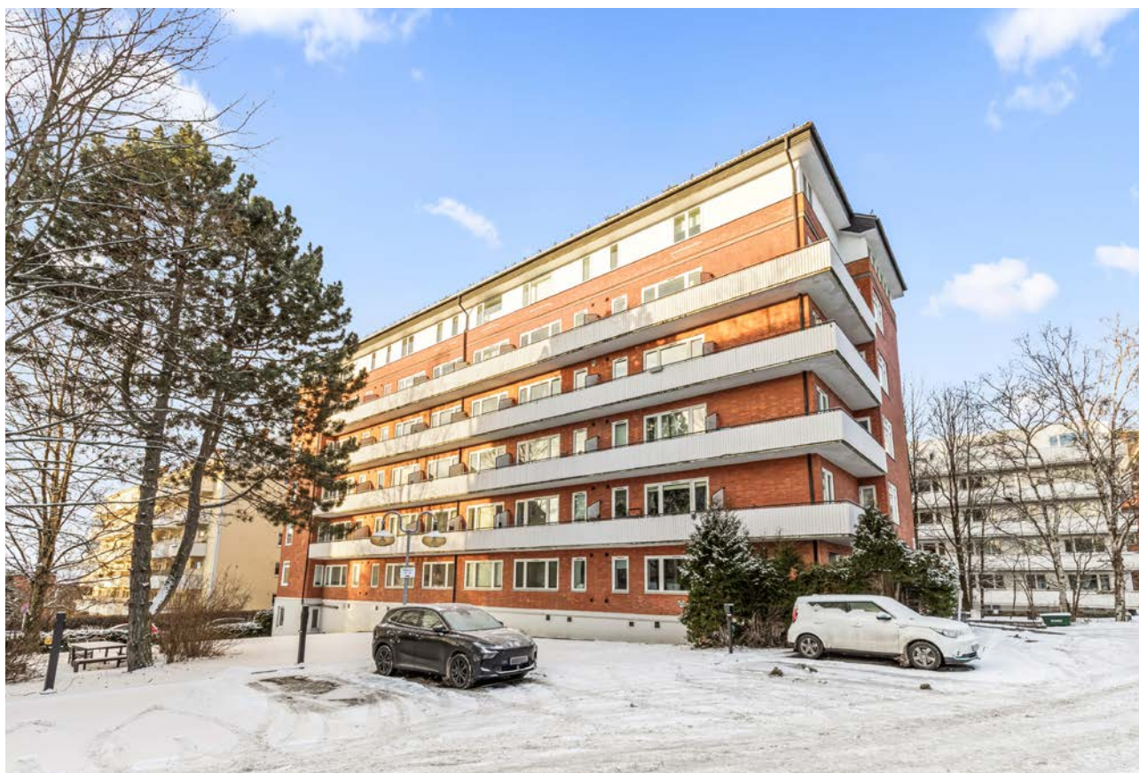
Ensjøveien 31B (32).JPG
