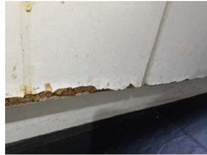
Svelleskader nederst på innredningen
