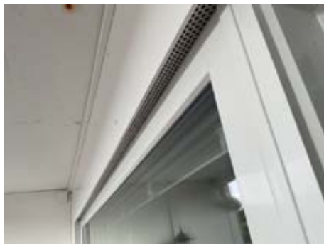
Luftespalte over vindu med rist.
