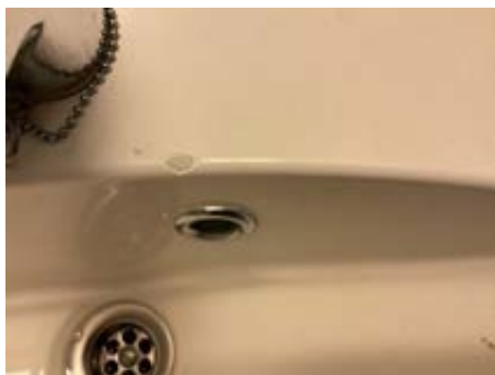
Skår i overflaten på vask.
