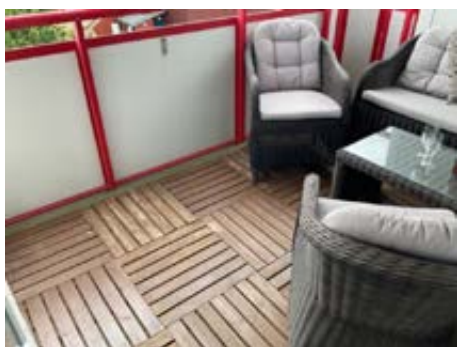
Tremmegulv uten tettesjikt mellom etasjene.
