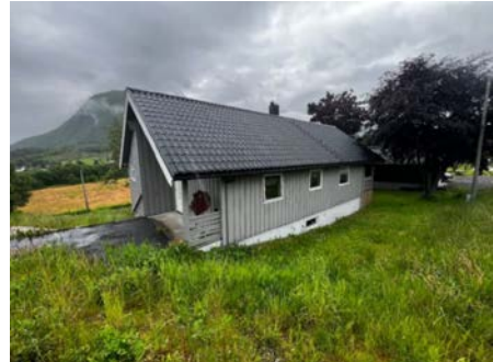
Oversiktsbilde av takteking.
