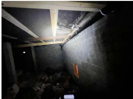
Fuktskader i etasjeskiller, synlig i fra krypkjeller.
