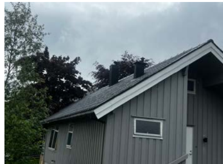
Oversiktsbilde av takteking.
