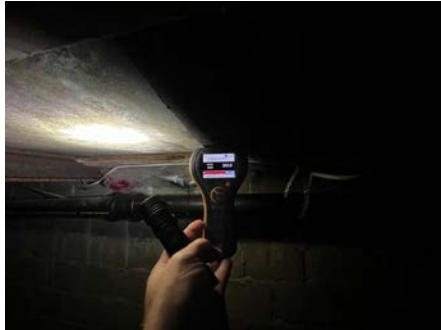
Fuktskader i etasjeskiller under kjøkken. (Disse bilder ble tatt den 17.06.2025)
