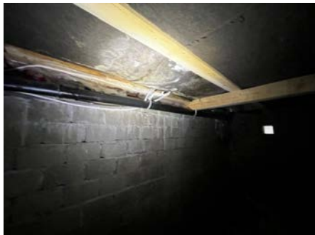
Fuktskader i etasjeskiller, synlig i fra krypkjeller.
