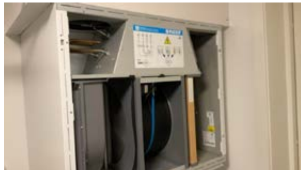
Flexit Nordic S4R balansert ventilasjonsanlegg
