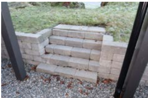
Forstøtningsmur/trapp av betongstein.
