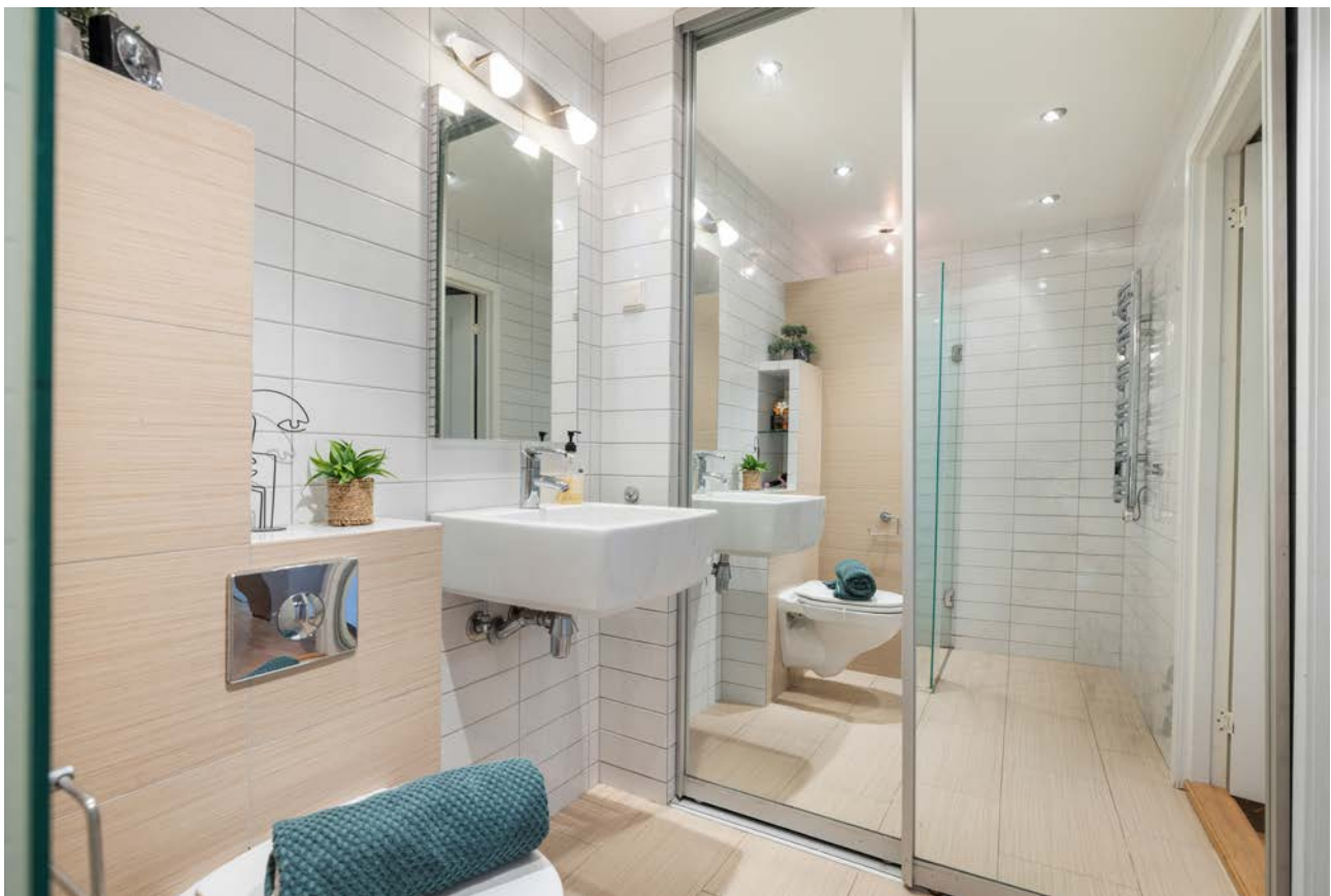
Baderomsinnredning bestående av veggmontert servant med ett-greps blande batteri, speil med veggmontert belysning, dusjhjørne med innfellbare dører i herdet glass, vegghengt toalett med innebygget systerne.
