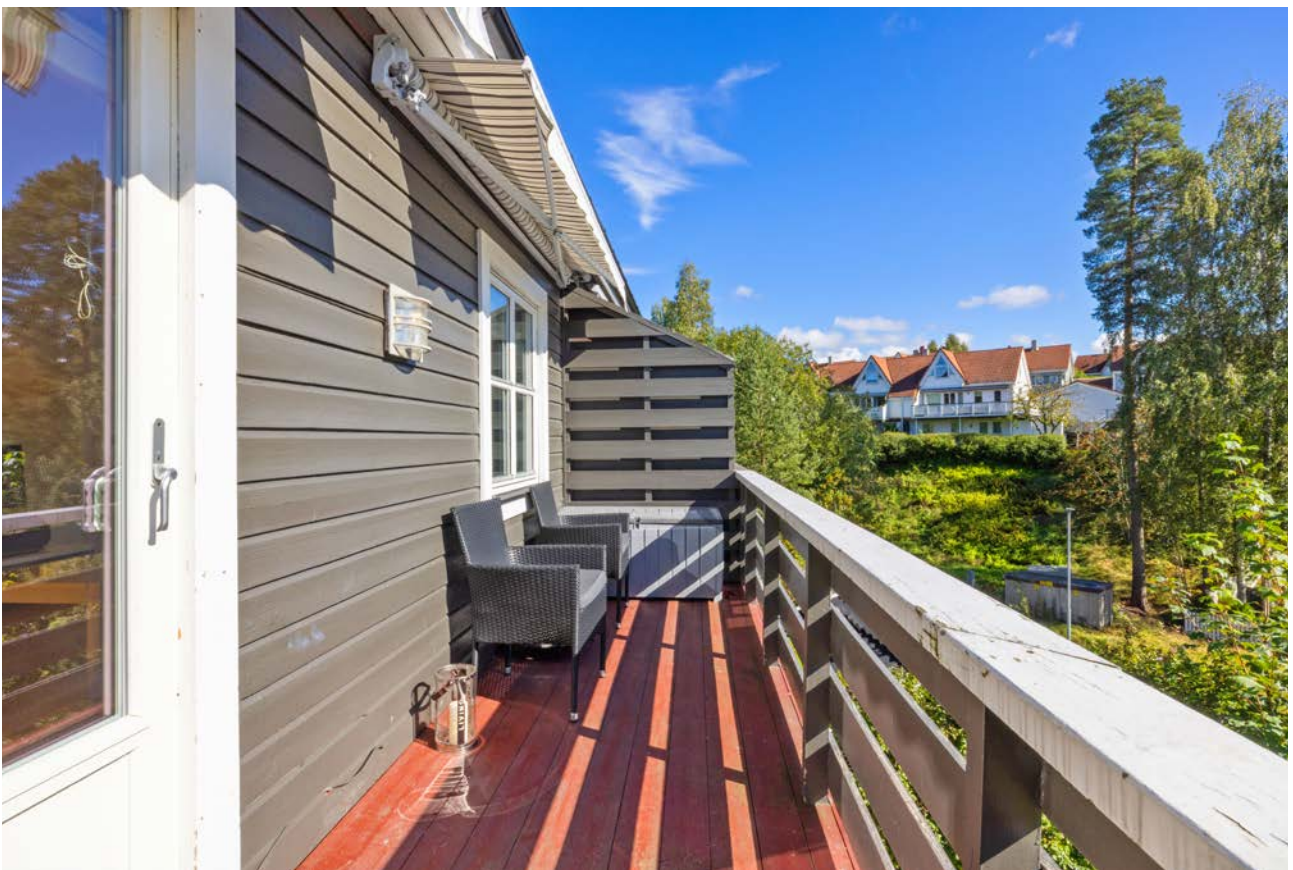
Rekkverk på veranda har malt trevirke med en høyde på 92cm. Det er brukt trykkipregnerte terrassebord.
