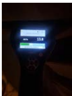
Det ble målt 13,8 vekt% i bunnsvill.
