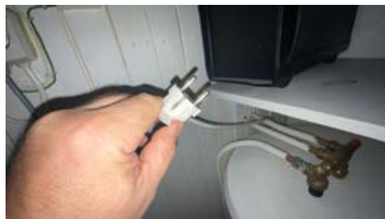
Ingen svimerker på stikk ved dagens befaring.
