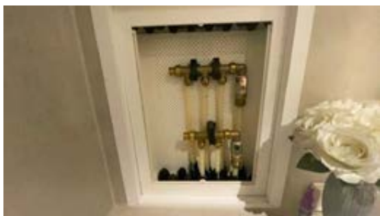
Rørskap på bad i 1. Etasje.
