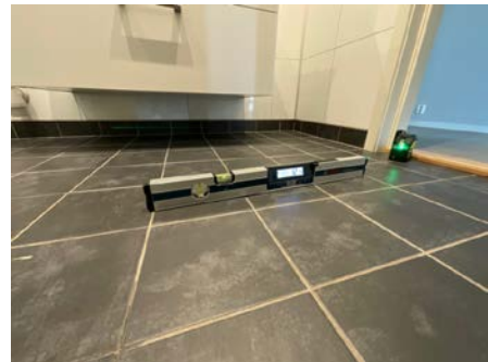
1:100 fallforhold utenfor dusjsone, dvs 10 mm per meter.
