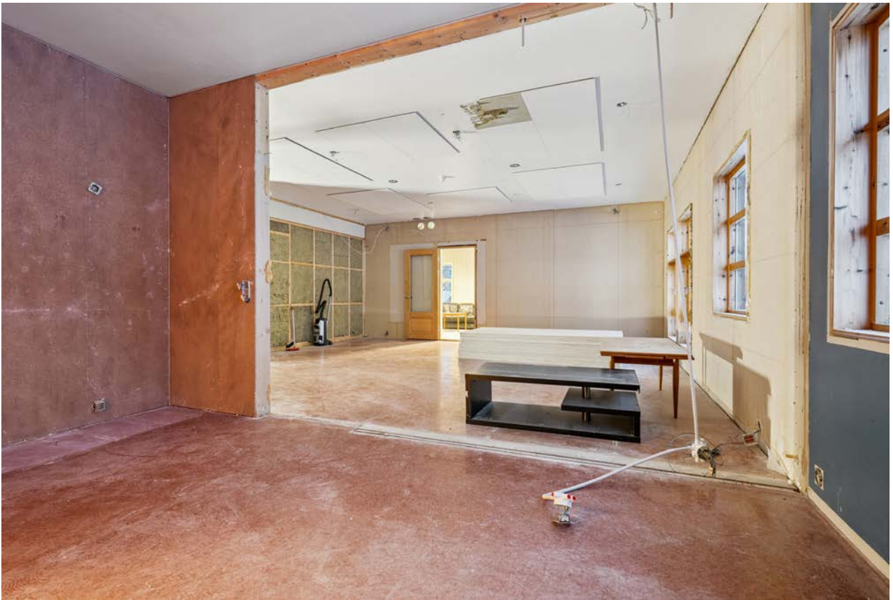
Under renovering/ombygging til fritidsleilighet
