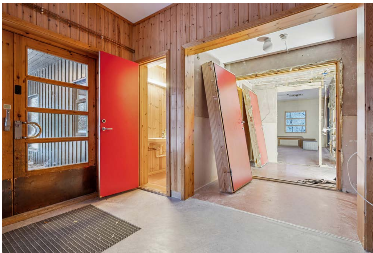
Inngangsparti- under ombygging/renovering til fritidsleilighet
