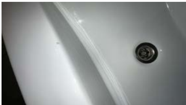
Mindre sår i overflaten på vask.
