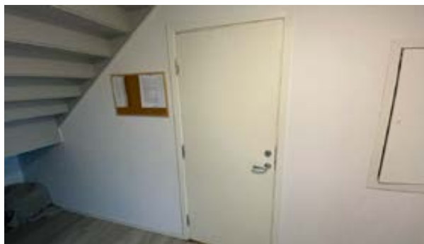
Entrédør mot felles gang/trapp.
