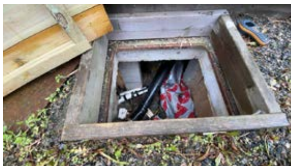
Tilkomm felles krypkjeller ved tilstøtende naboer.
