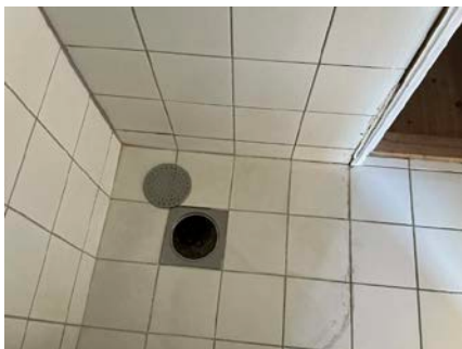
Sluk bad hovedetasje
