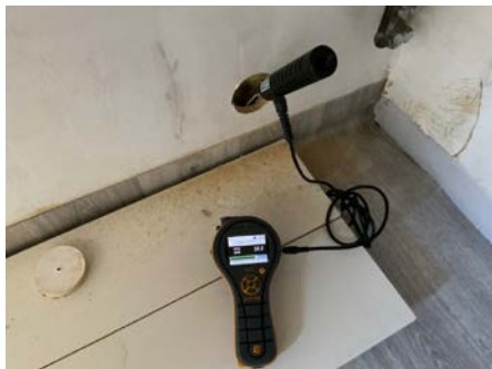
Hulltaking og fuktmåling
