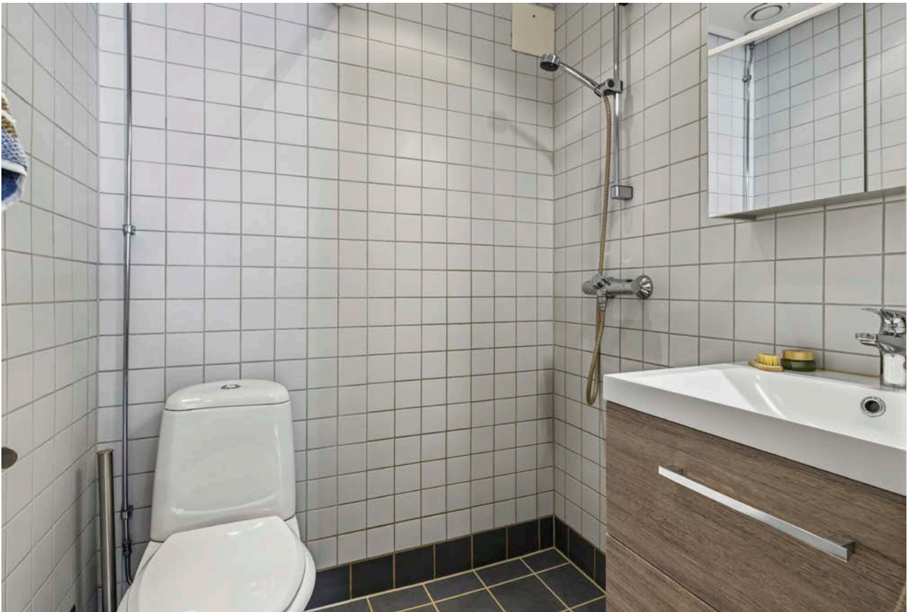
Flislagt bad/wc med varmekabler i gulv. Veggene er flislagte og himlingen er malt. Bad pusset opp 2006 i regi av borettslaget. Baderomsgulvet fikk nye varmekabler, støp og fliser i 2018.
