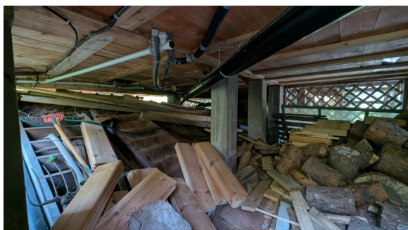
Bjelkelag sett fra undersiden.
