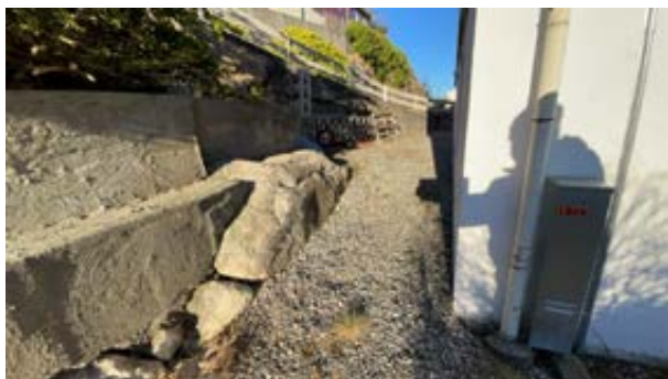
Fall langs bygning mot øst og vest.
