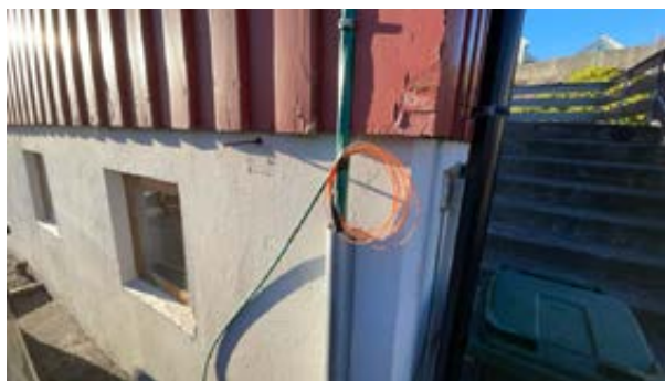
Fiber lagt frem til yttervegg.
