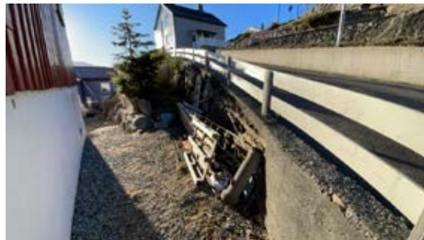
Støttemur mot offentlig vei/gate.
