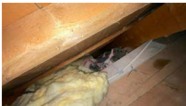
Manglende luftespalte mot varme rom.
