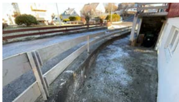
Støttemur mot offentlig vei/gate.
