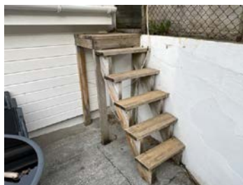
Manglende rekkverk med råteskade i øverste trinn.
