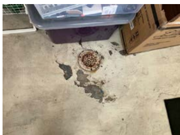
Gammel støpejernssluk.
