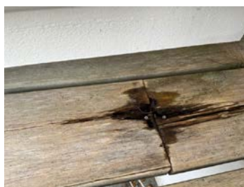
Manglende rekkverk med råteskade i øverste trinn.
