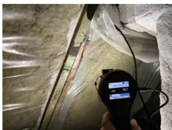
Fuktmåling rundt pipe.
