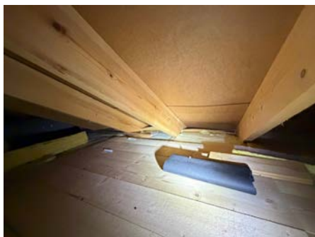
Full isolert takkonstruksjon. Ingen forhold som tyder på kondensproblematikk.
