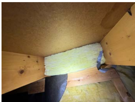
Full isolert takkonstruksjon. Ingen forhold som tyder på kondensproblematikk.
