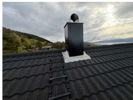
Skorstein over tak.
