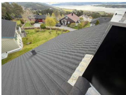
Oversiktsbilde av taktekkning.
