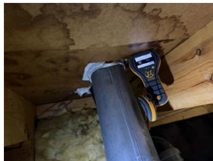
Fuktmåling i undertak ved luftelyre, ikke utslag på fukt.
