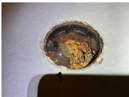
Sluk i bod med støpejern.
