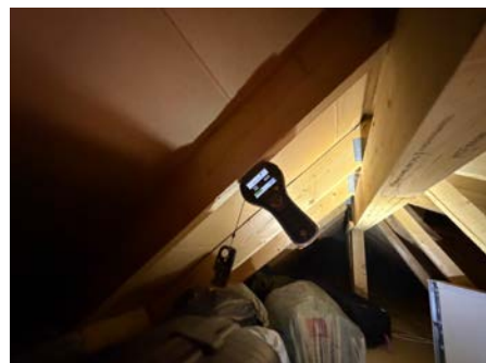
Oversiktsbilde av taktekking.
