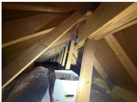
Fuktmåling. Ikke utslag på fukt.
