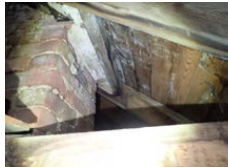
Fukt/råteskadet trobord
