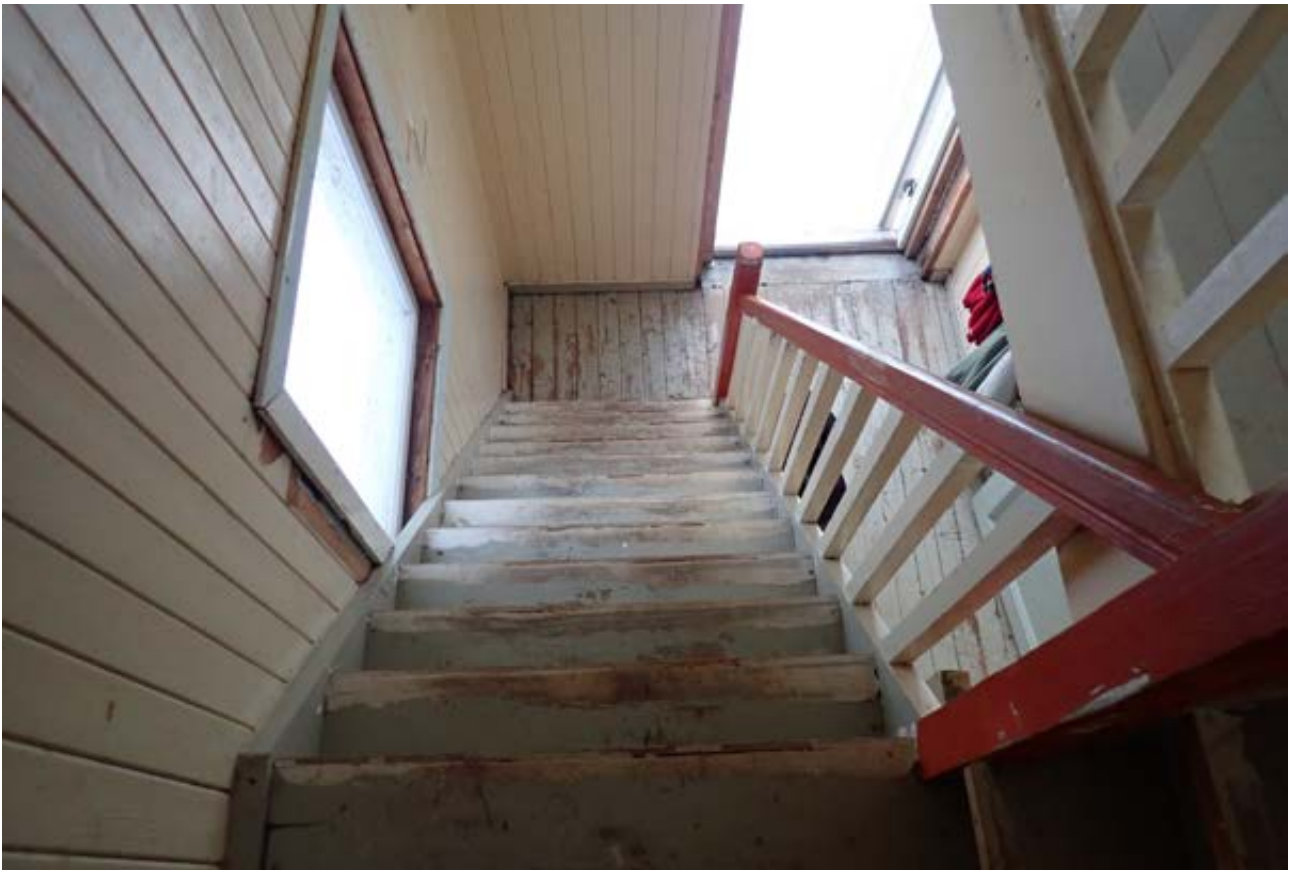
Trapp fra 2 etasjen ned til gangen i førsteetasjen
