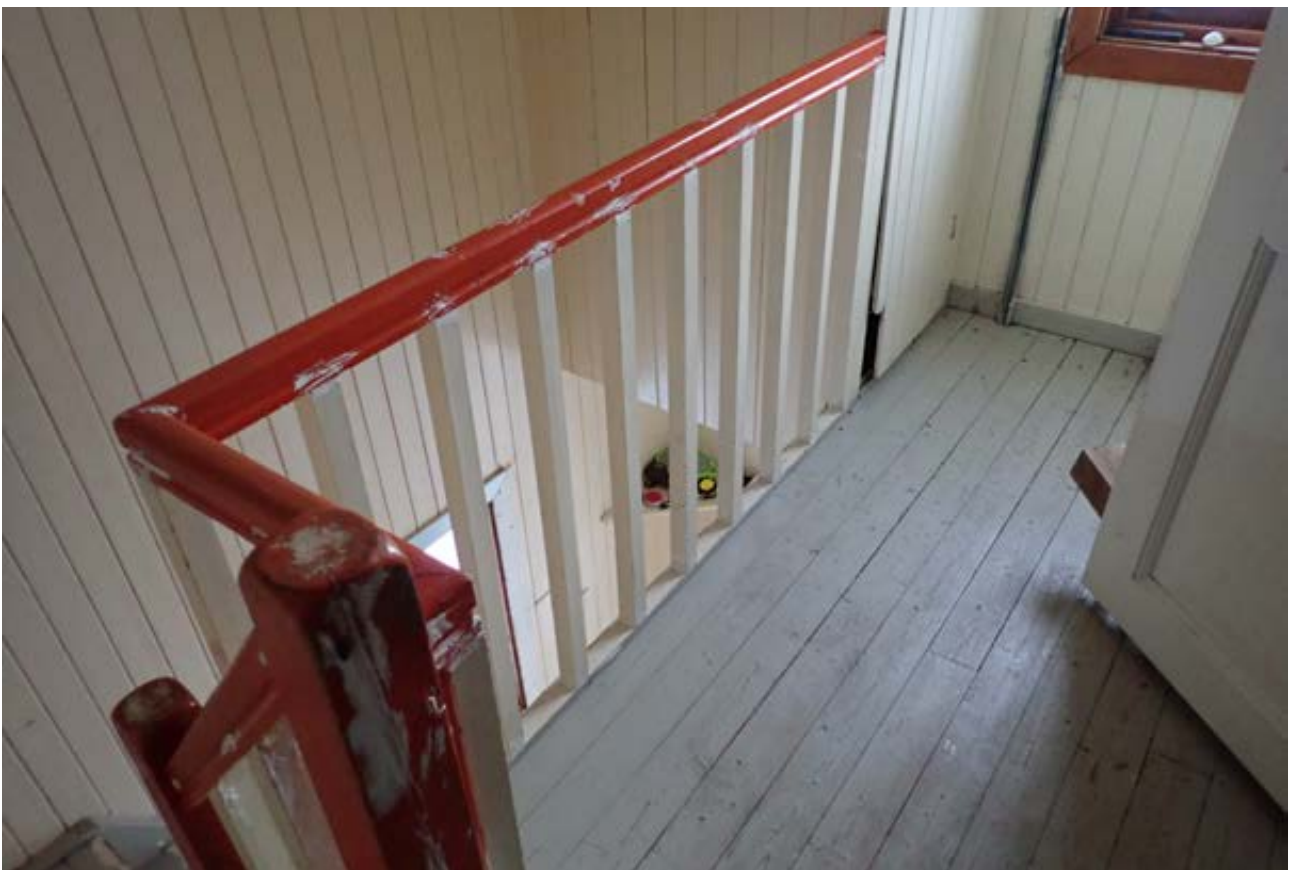
Del av gang i 2 etasjen
