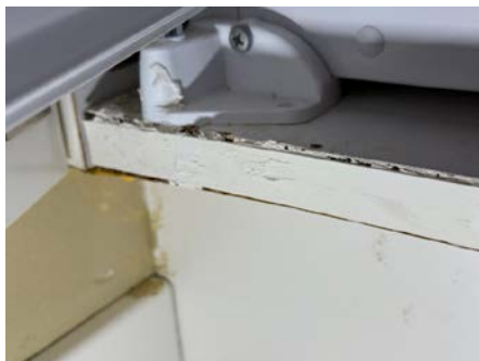
Fuktsvelling i skrog under kjølfrysenskap
