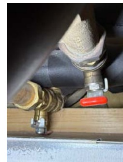
Vanskelig adkomst for 1 av 2 stoppekraner i baderomshimling
