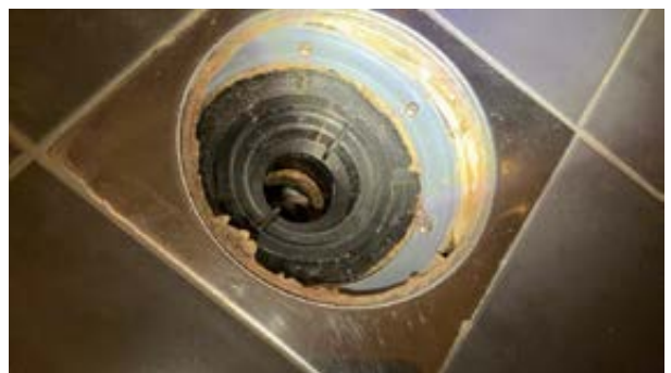
Sluk på bad/vaskerom
