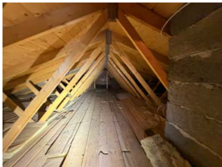
Fuktmåling, ikke utslag på fukt.
