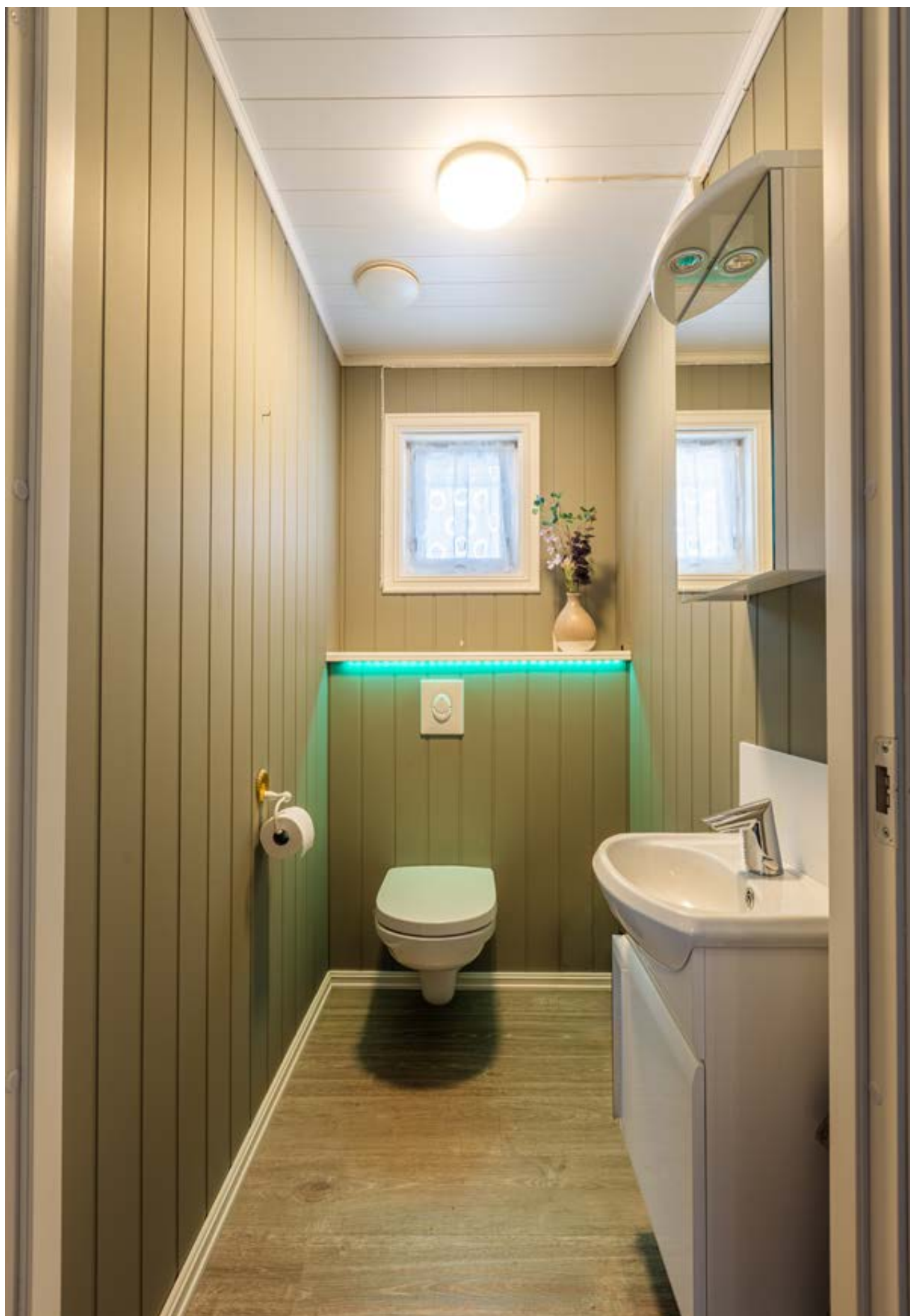
Toalettrommet er oppgradert i 2024 og har naturlig avtrekk, men mangler mekanisk ventilasjon.
