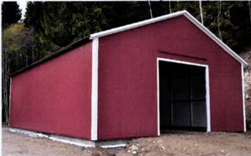
OMEGA LAGERHALL UNDER OPPFØRING TOCKSFORS HØSTEN 2013. HALLEN HAR SANDWICHPLATER OG VINDUER VIL BLI INNSATT ETTERPÅ. 10 X 14 X 4
