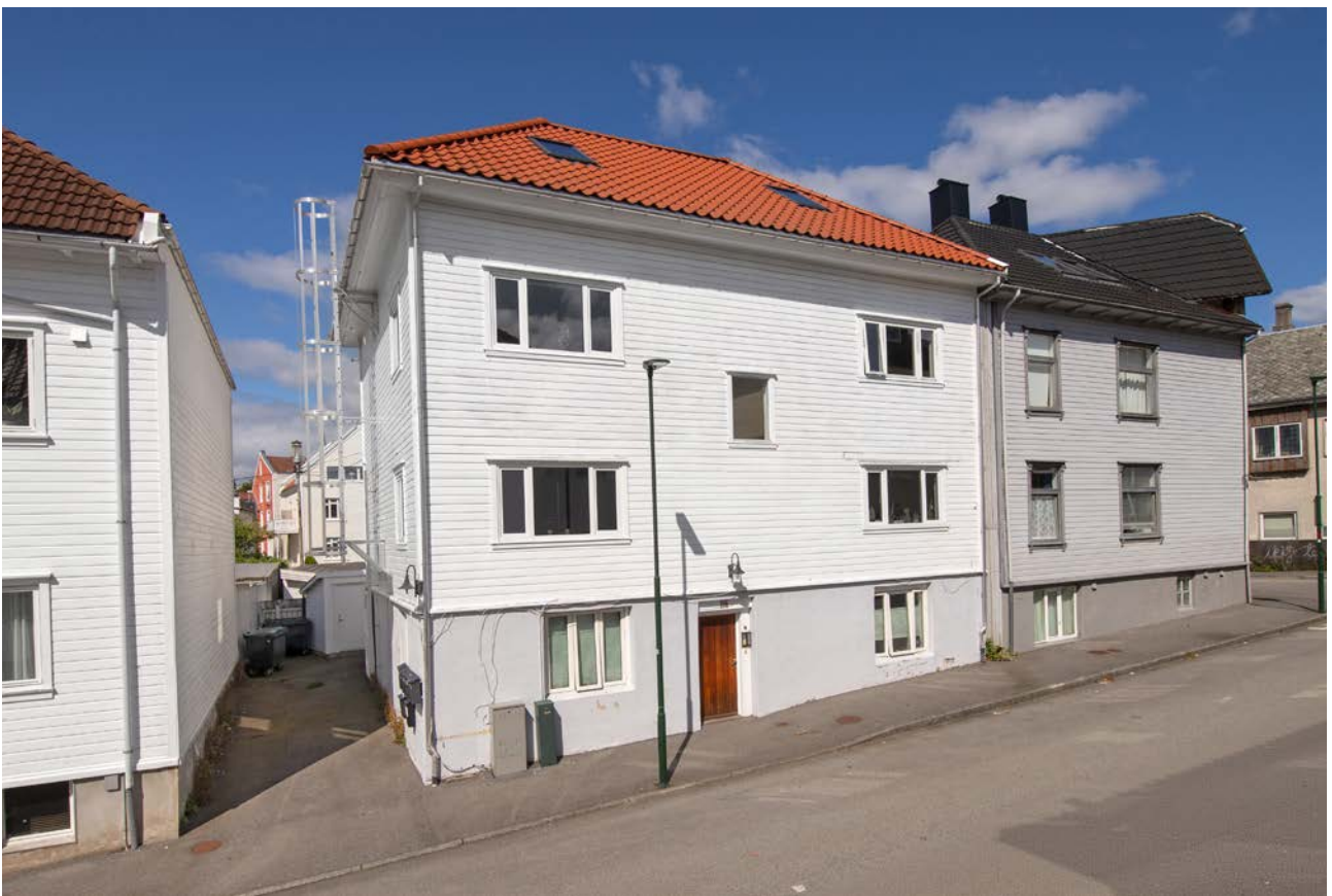
Sameiet skiftet tak og malt kledningen/skiftet nødvendige bord i 2020
