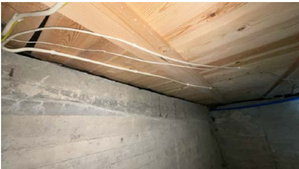
Besiktigelse av kryprom.
