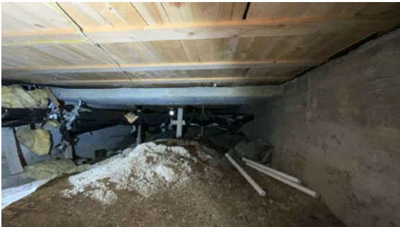
Besiktigelse av kryprom.
