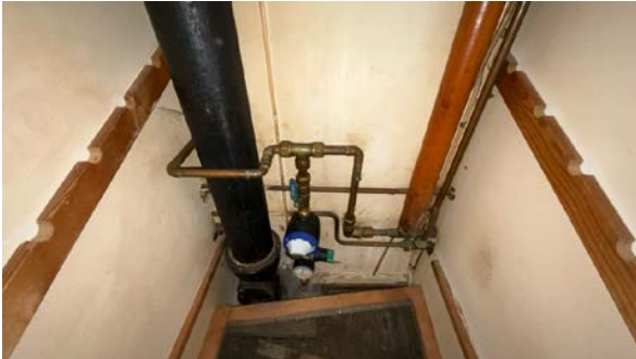
Besiktigelse av røropplegg.
