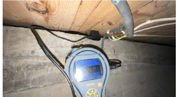
Utført fuktmåling på trevirke mot grunnmur. Moderat fuktprosent på befaringdagen.
