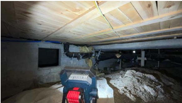
Besiktigelse av kryprom.
