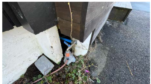
Besiktigelse av rørøpplagg.
