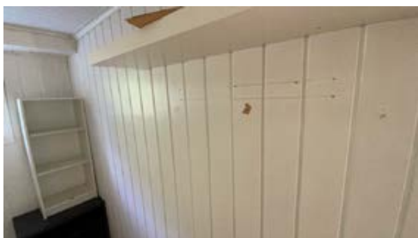
Merker etter innfestning på vegger.
