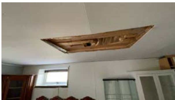
Åpnet himling i etasjeskille mot etasje over.
