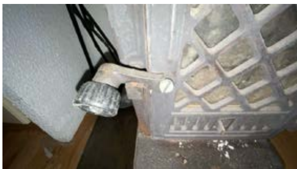
Defekt låsemekanisme på vedovn
